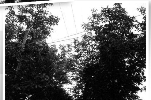
A diófa ágai kiefeszültségű szigetetlen hálózatban, életveszélyes (szélben a faágak összeverik a fázisvezetőket, ezzel időleges áramszünetet okozva)
